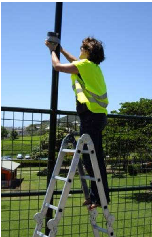
Installation des boîtes et des échantillonneurs passifs
